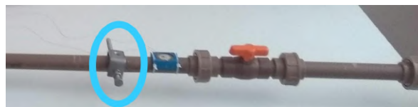
Figura 2: Tubulação com dano.
